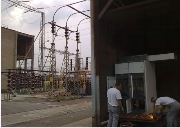
Priprema ćelije za testiranje otpornosti na luk
